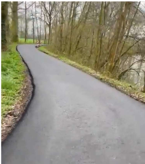
Vossegatsepap met nieuw asphalt
