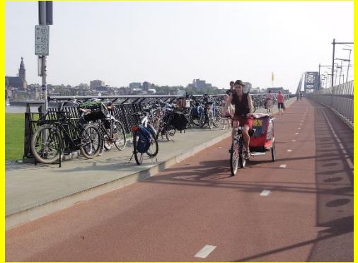
Fietsbrug "Snelbinder" over de Waal (Nijmegen)
