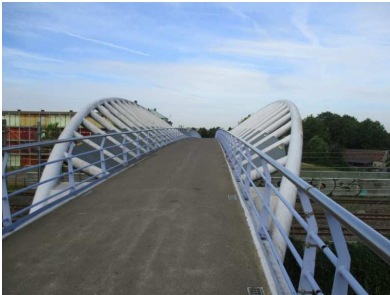
Vijfwalbrug over het spoor (2009)
