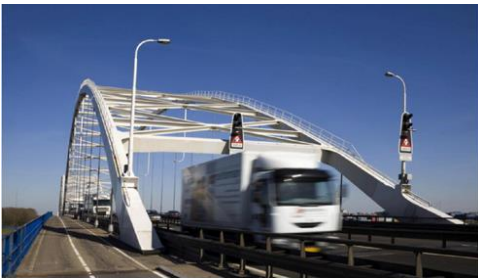
De Jan Blankenbrug met fietspad in de A2
