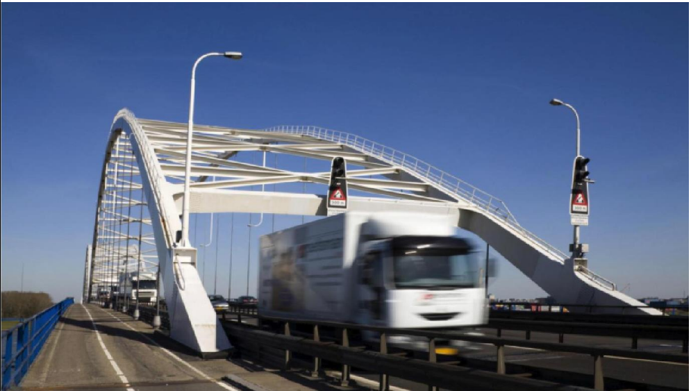
Jan Blankenbrug in A2 met fietspad
