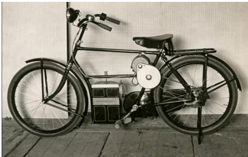
Elektrische fiets uit 1932 (octrooi Philips, vervaardigd door Simplex)
